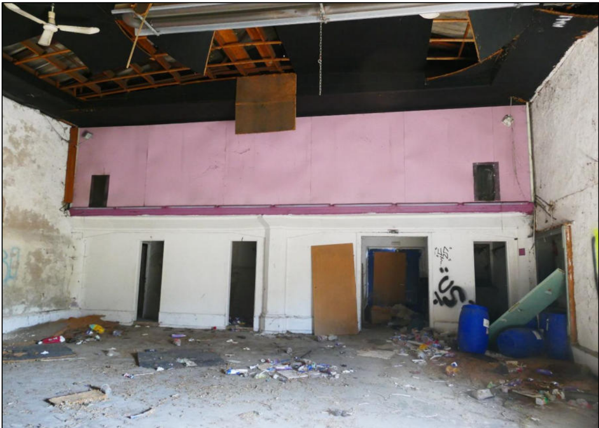
Abbildung 20: Für einen Abriss vorgesehene ehemalige Kinohalle mit offener Zwischendecke und Spuren von Vandalismus. (Foto: IBU, 04/2025).
