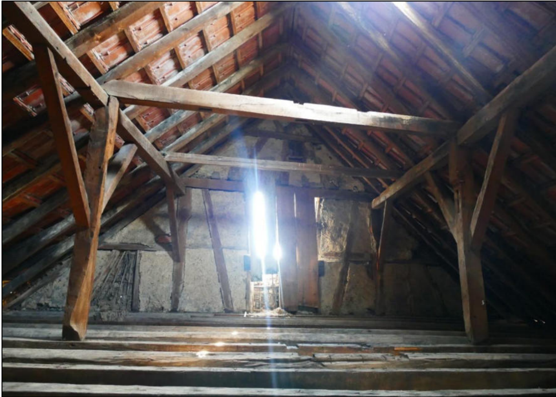
Abbildung 17 Dachboden von Haus 1. Der Dachboden verfügt über zahlreiche Spalten nach außen. Haus 2 verfügt über einen ähnlich beschaffenen Dachboden (Foto: IBU, 04/2025).
