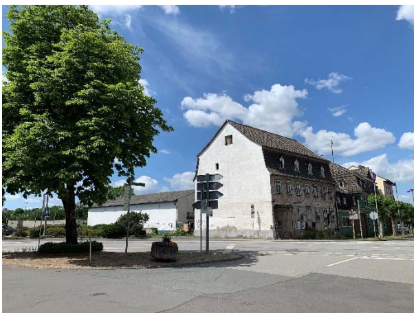
Blick Richtung Südwesten auf Kreuzung Wormser Straße/Rheinstraße
