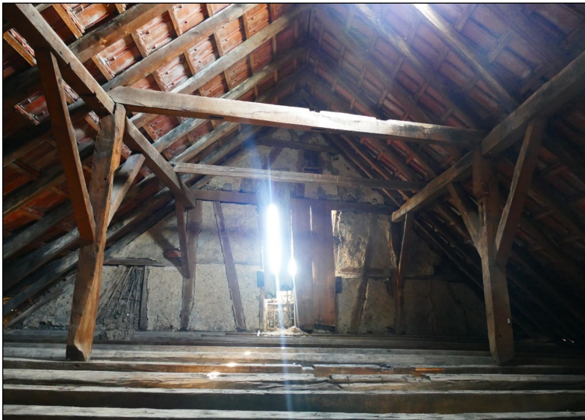
Abbildung 8: Dachboden von Haus 1. Der Dachboden verfügt über zahlreiche Spalten nach außen. Haus 2 verfügt über einen ähnlich beschaffenen Dachboden (Foto: IBU, 04/2025).
