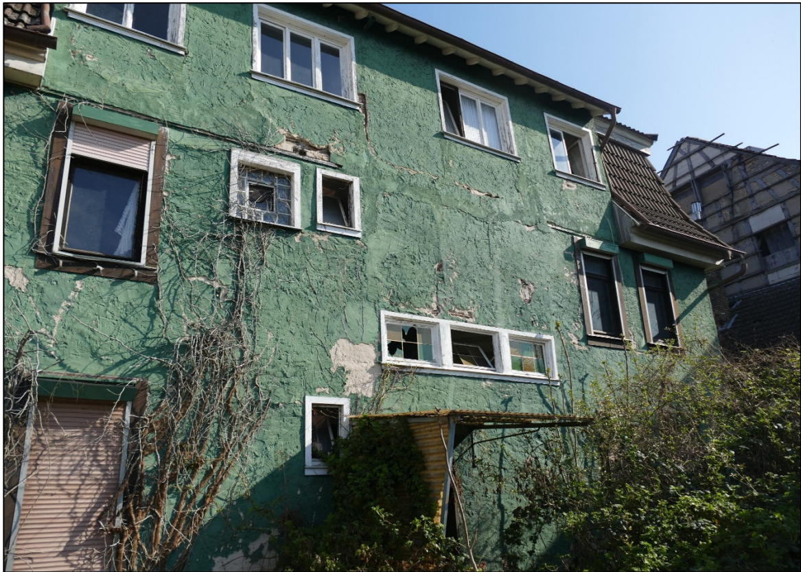
Abbildung 9: Straßenabgewandte Seite von Haus 2 mit teilweise geöffneten Fenstern (Foto: IBU, 04/2025).
