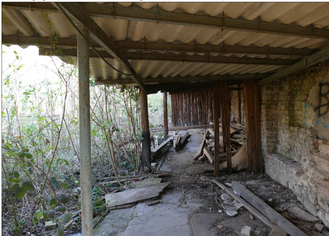
Abbildung 6: Im Bereich der Gartenfläche befinden sich zahlreiche Hütten und Verschläge mit Backsteinmauern (Foto: IBU, 04/2025).
